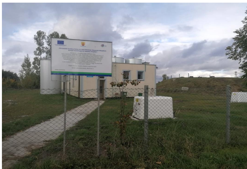
Fot. 1 i fot. 2 – Nowe zbiorniki na wodę i budynek SUW Płowce (archiwum Urzędu)
