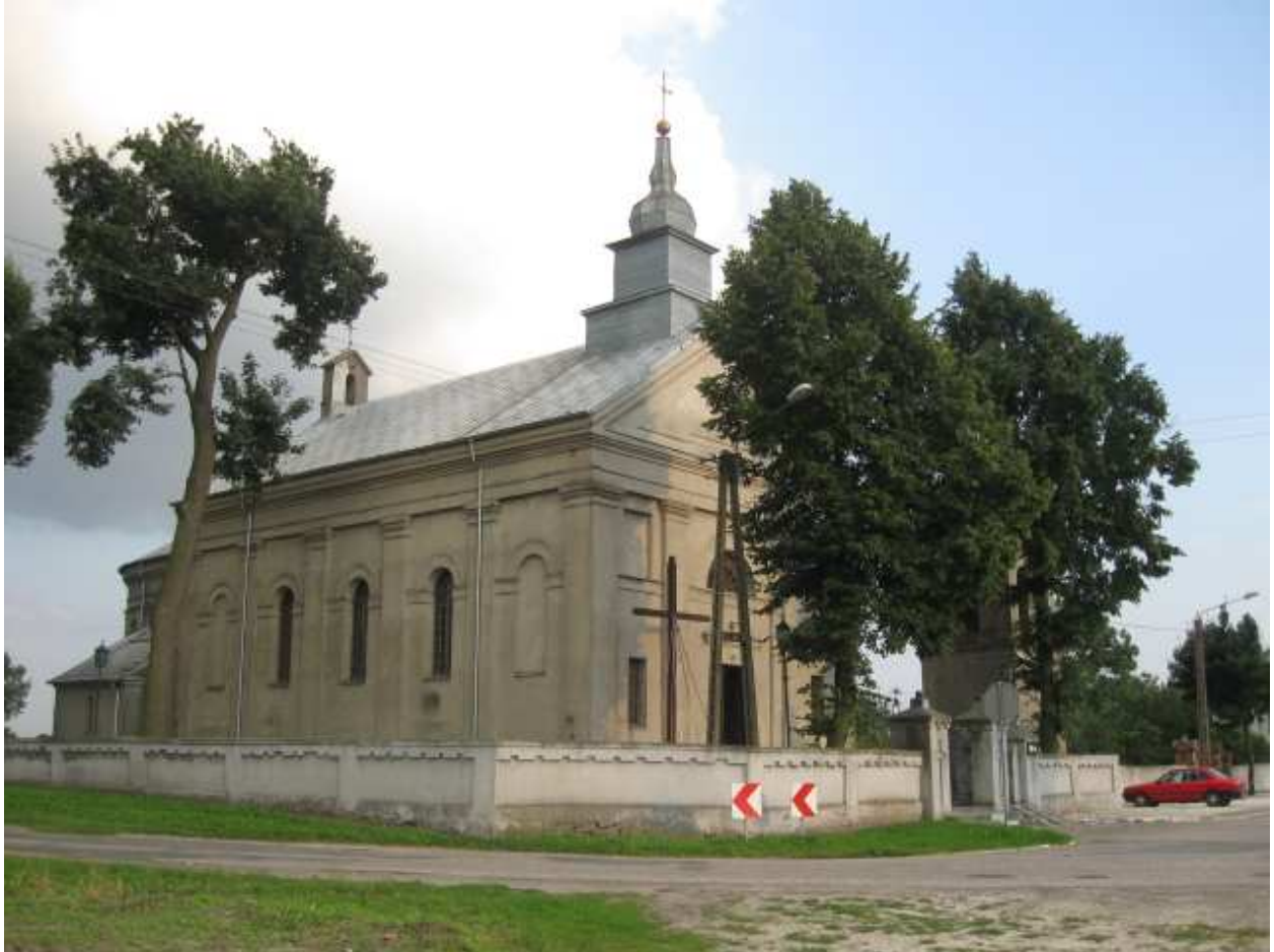
Zespół kościoła parafialnego p.w. św. Wojciecha i Barbary. Widok na kościół, dzwonnice i ogrodzenie od strony północno - zachodniej.
