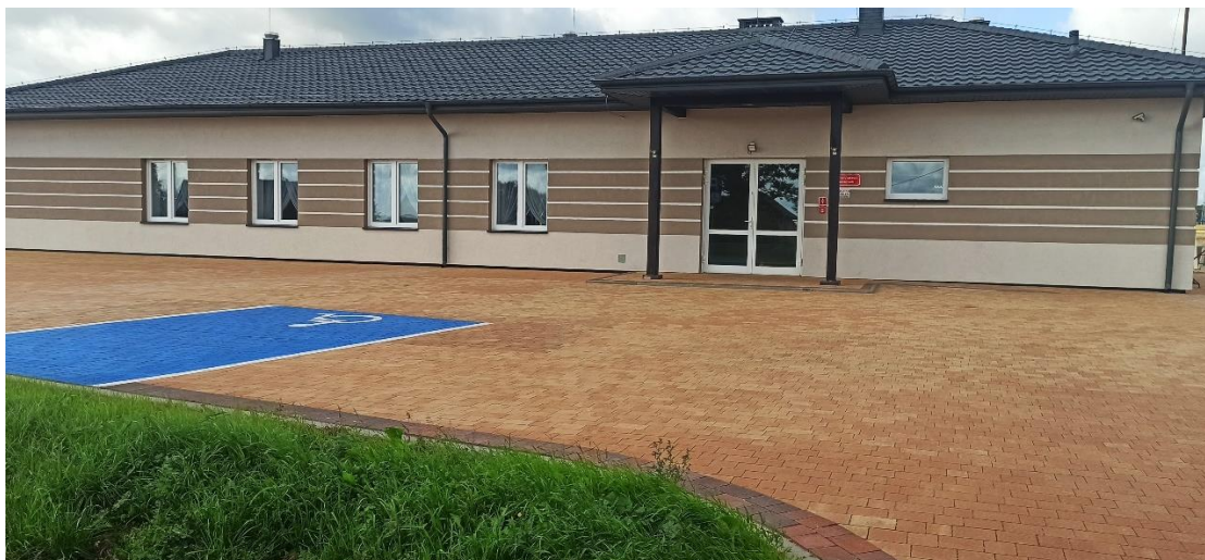
Fot. 1, fot. 2, fot.3 – Zagospodarowanie terenu wokół świetlicy wiejskiej w Zagorzycach (arch. UG)
