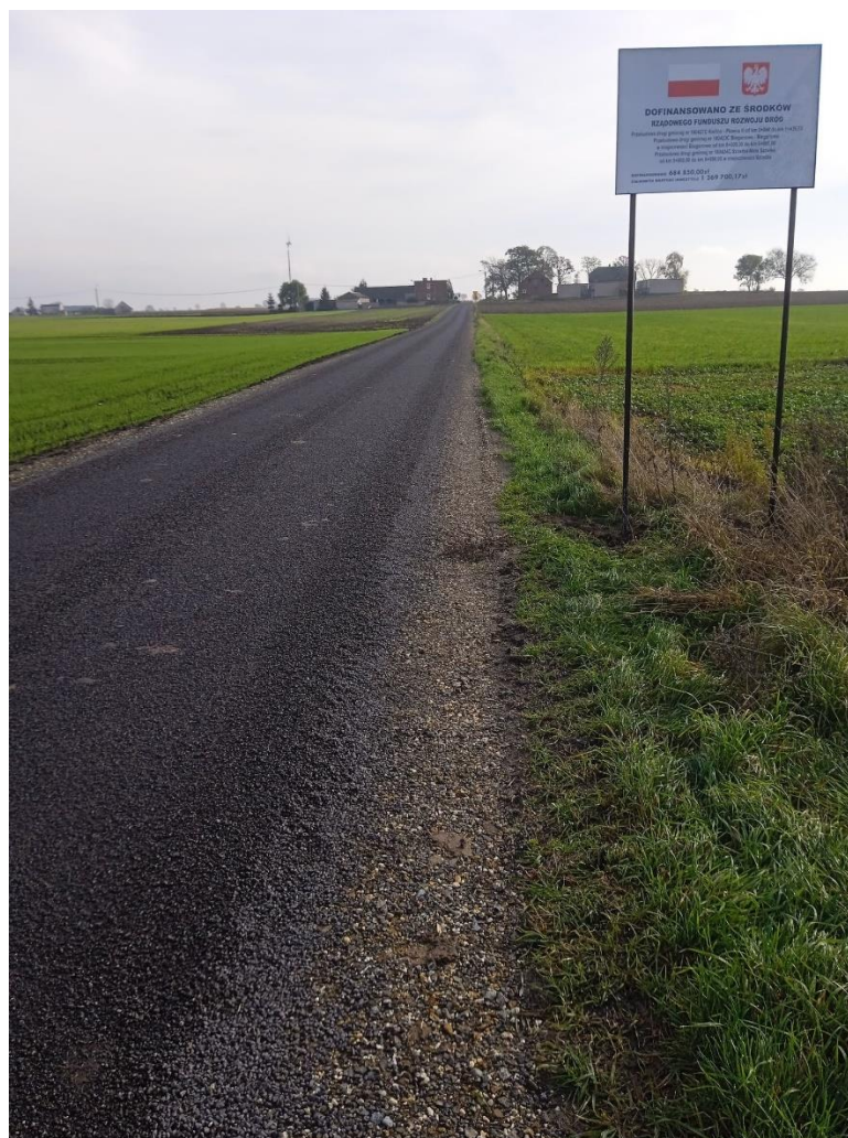
Fot. 5 – Przebudowa dróg gminnych (archiwum Urzędu)
